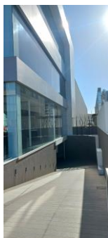
Fachada lateral (entrada parking)
